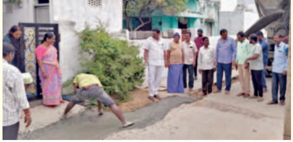
ఇడబ్బుఎన్కాలనీలో సీని రోడ్డుకు మరమ్మత్తు పనులు చేయిస్తున్న మున్సిపల్ చైర్మన్చైర్మన్ మాధవరెడ్డి
